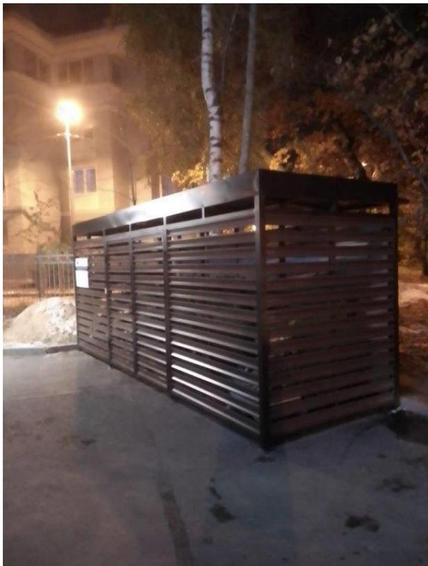
Закрытая контейнерная площадка с двумя дверями для входа и выкатывания баков .
